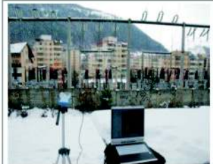
Fig. 4: Stand lângă stația de transformare, cartierul Răcădău, Brașov
