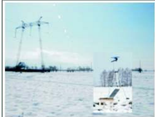
Fig. 3: Stand în detaliu lângă linia electrică cartierul Stupini, Brașov
