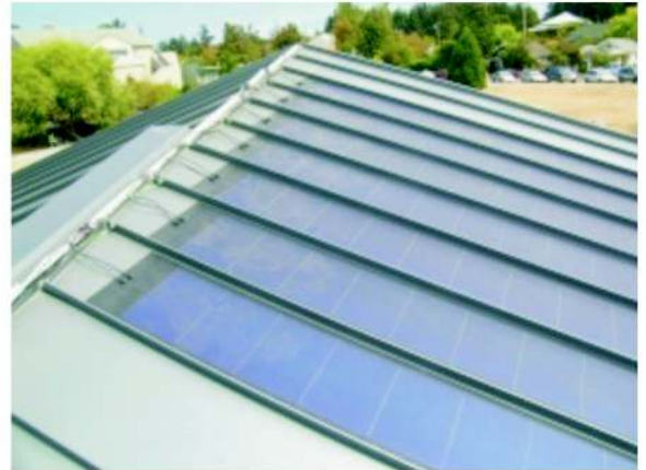
Fig. 6: Panouri solare pe un acoperiș [5]
